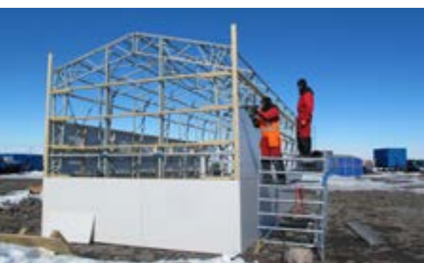
Vanhan helikopterihallin päällystystöitä. Installation of a new cover for a helicopter shelter. Kuva: FINNARP
