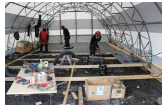
Kaari- eli telttahallin rakennustyöt. Refurbishment of the tent hall.
