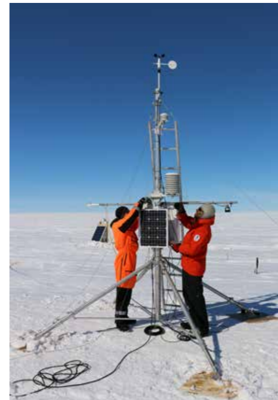
Uuden sääaseman asennus. Installation of the new weather station.
